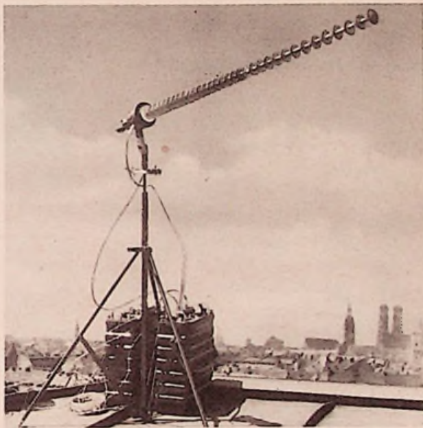
Multiplex-Richtstrahl-Anlage der französischen Firma SFR für drei Gesprächskanäle auf 2000 MHz ( \lambda = 15 cm). Die „Zigarrenan-tenne“ war vom Dach des Deutschen Museums zum Flughafen Riem gerichtet, um unmittelbare Sprechverbindungen während der Funkortungstagung zu ermöglichen.
